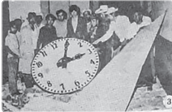
Imagen de los daños ocasionados por el terremoto de 1976 en la Municipalidad de Chiquimula (Anónimo).
