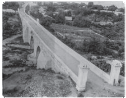
Puente El Molino, hacia 1930 (Guido Lobos).
