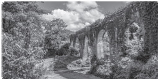
Acueducto, Esquipulas (Juan Pablo Espino Villela).
